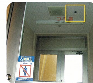
汚物庫（ごみ庫）内のオゾンエアー薫蒸
